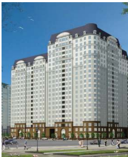
Chung cư CT3 - Khu ĐTM Cổ Nhuế - 13 tầng
