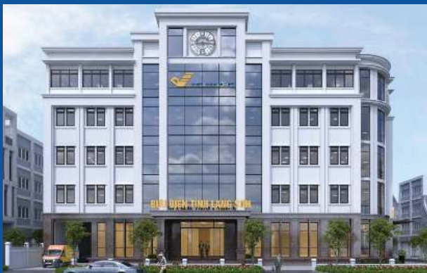
Khu nhà 5 tầng - Bưu điện tỉnh Lạng Sơn
