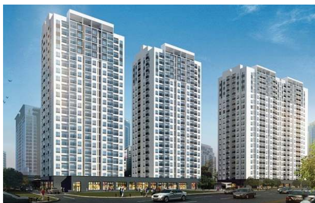
Tòa nhà CT01, CT02 Khu nhà ở cán bộ nhân viên Viện 103 - 12 tầng
