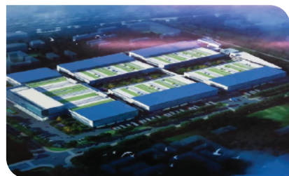
Nhà máy Shunsin Việt Nam Địa chỉ: KCN Quang Châu, Bắc Giang 4 tầng
