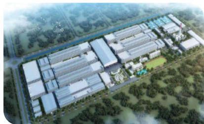
Nhà máy công ty TNHH công nghệ bảo hộ Kalongda Việt Nam Địa chỉ: Xã Phong Hòa, Huyện Phong Điền, Tỉnh Thừa Thiên Huế 32 tầng
